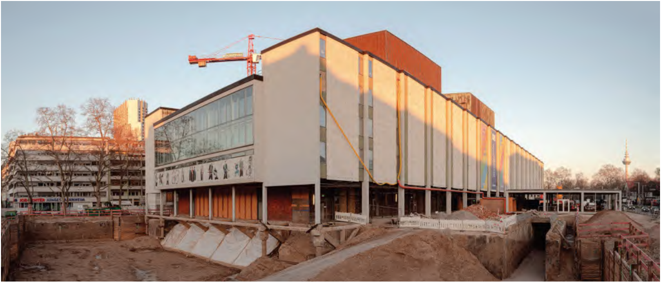
Baugrube am Goetheplatz für die künftigen Präsenzwerkstätten des Nationaltheaters Mannheim, Januar 2024. Foto: Maximilian Bor
